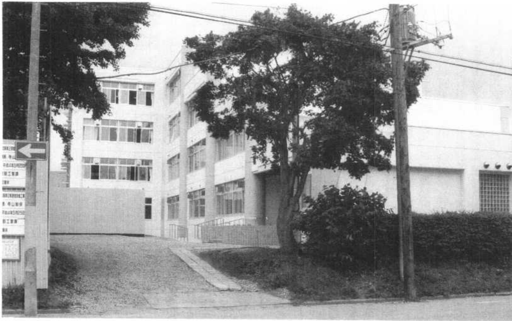
写真は、表紙の下のパースの右側部分ができあがった姿である。ややわかりにくいだが、薄い黒色になっている三本の柱が、「白楊の幹」を模した「円柱」である。
